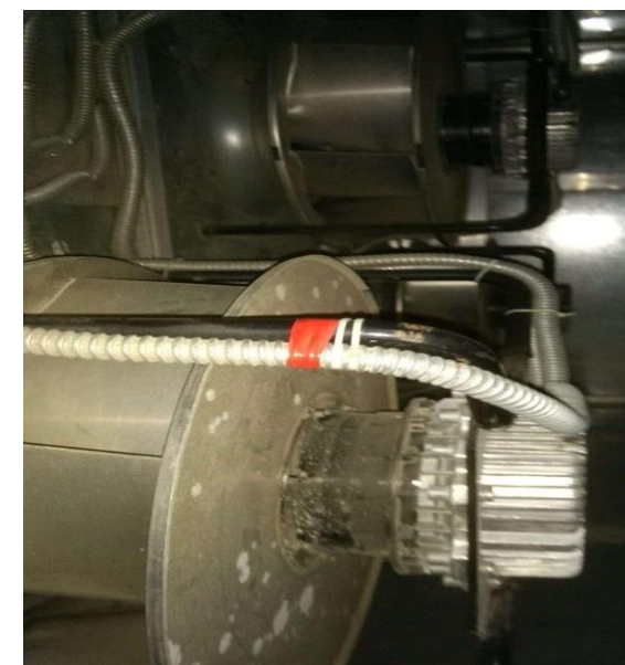
EC Fan Retrofitting
